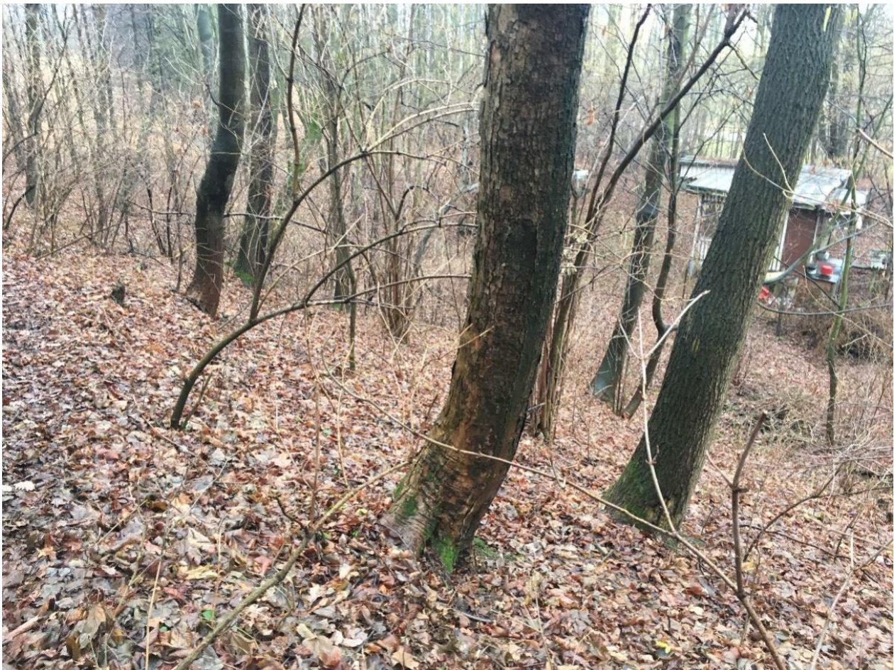
Obrázek 12: Projevy svahového ploužení na vzrostlé stromové vegetaci (staničení cca km 13.550)
