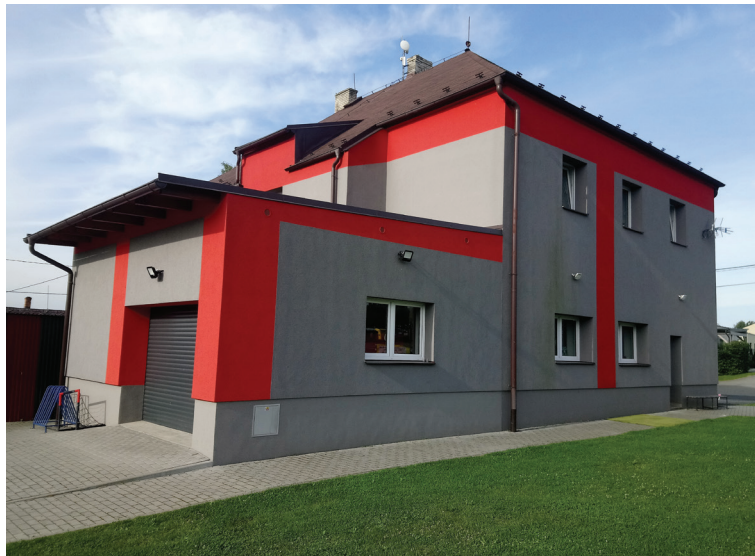
Přístavba požární zbrojnice – nyní už bez vedení VN
